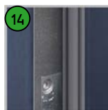
Uszczelka pęczniująca (drzwi PPOŻ)
